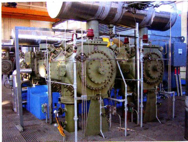
Рис. 2. Поршневой компрессор типа 4HF/2 (*Nuovo Pignone*)
